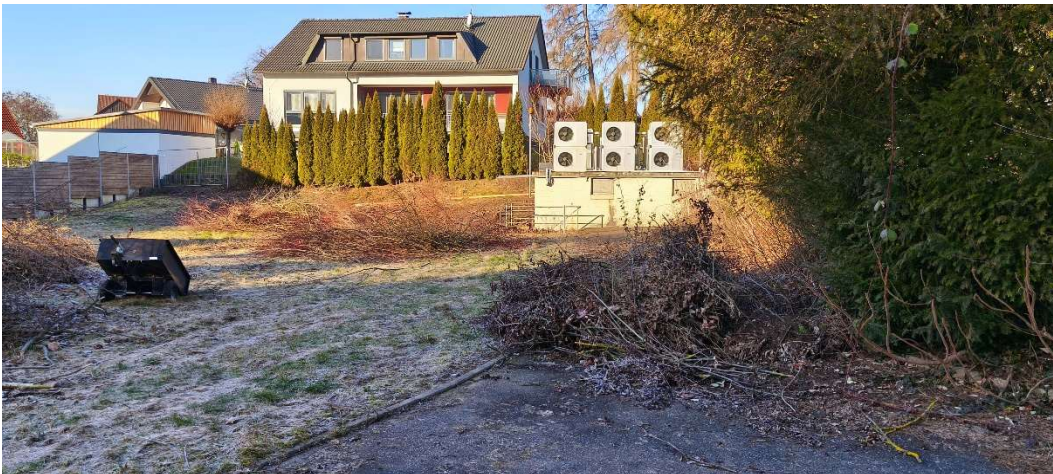
Baufeld und Lagerfläche
