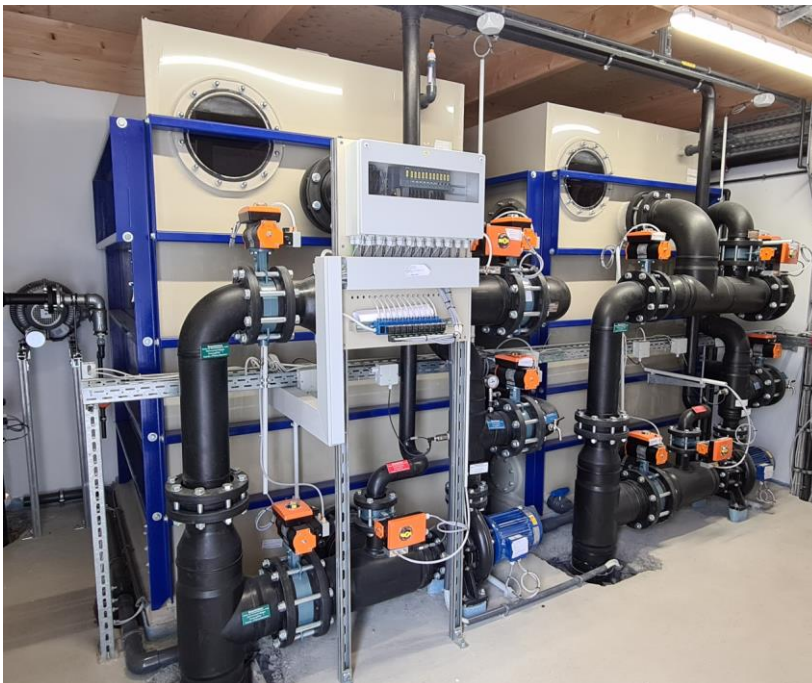
Abbildung: Offene Ansaugfilter, Beispiel, hier 2 x 2,5 m 2
