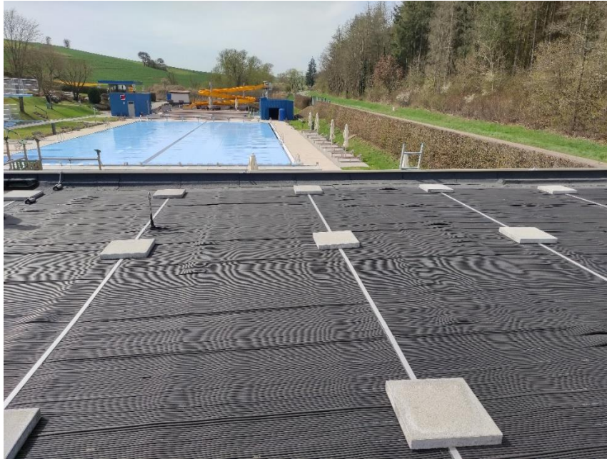
Abbildung: Solarabsorber speziell für Freibäder aus EPDM- Kautschuk
