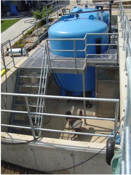
Abbildung: Filter- Außenaufstellung, Beispiel
