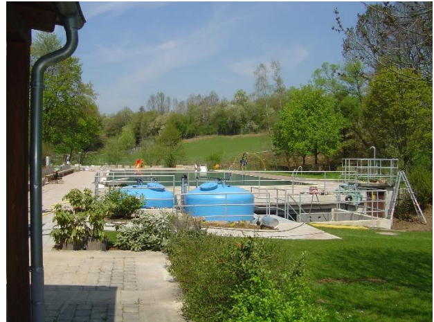
Abbildung: Filter- Außenaufstellung, Beispiel
